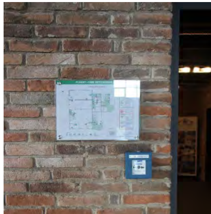
© Elektro Buchmann, Wehrheim
