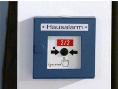
Funk-Handfeuermelder melden dank Manipulationsüberwachung auch jede unerlaubte Öffnung der Gehäusetür.
